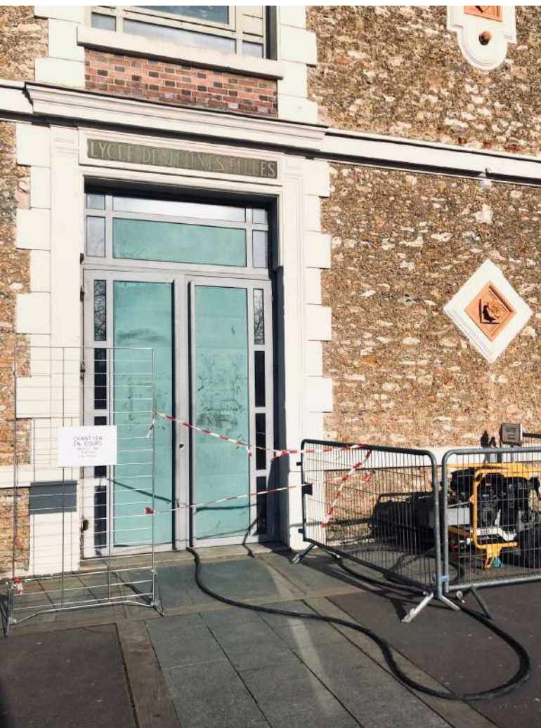
compresseur et sablage de la pierre
